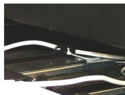
Фото 4: фиксация сигнальных кабелей
